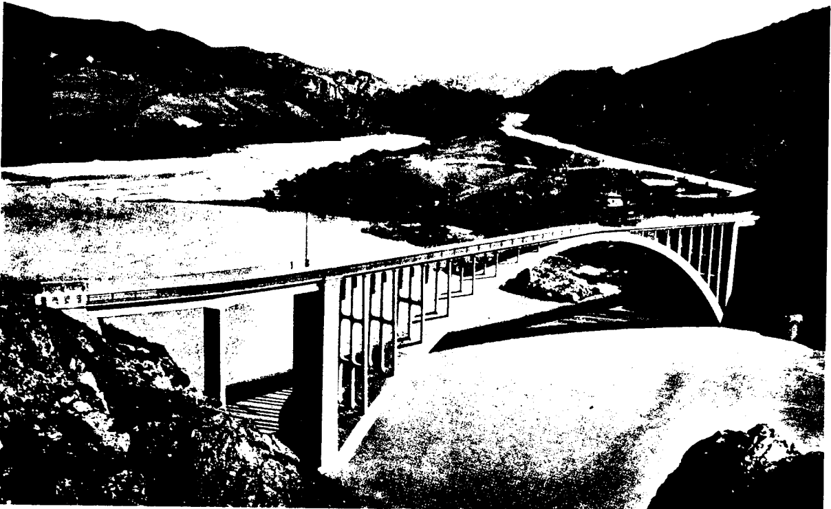
Եփրատ գետի վրայ ձգուած Յար կամուրջը եւ մամբան որ դէպի Խարպուդ կ'երկարի, դէպի Ծովք դղեակը: Vue du pont sur l'Euphrate et de la route vers Kharpout et vers la forteresse de Zovk.
