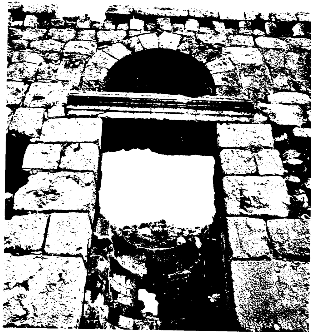
Մատրամ մուտքը դուրսէն դիտուած (Ֆ. Մարրա): Vue extérieure de l'entrée de la chapelle (F. Marra).
