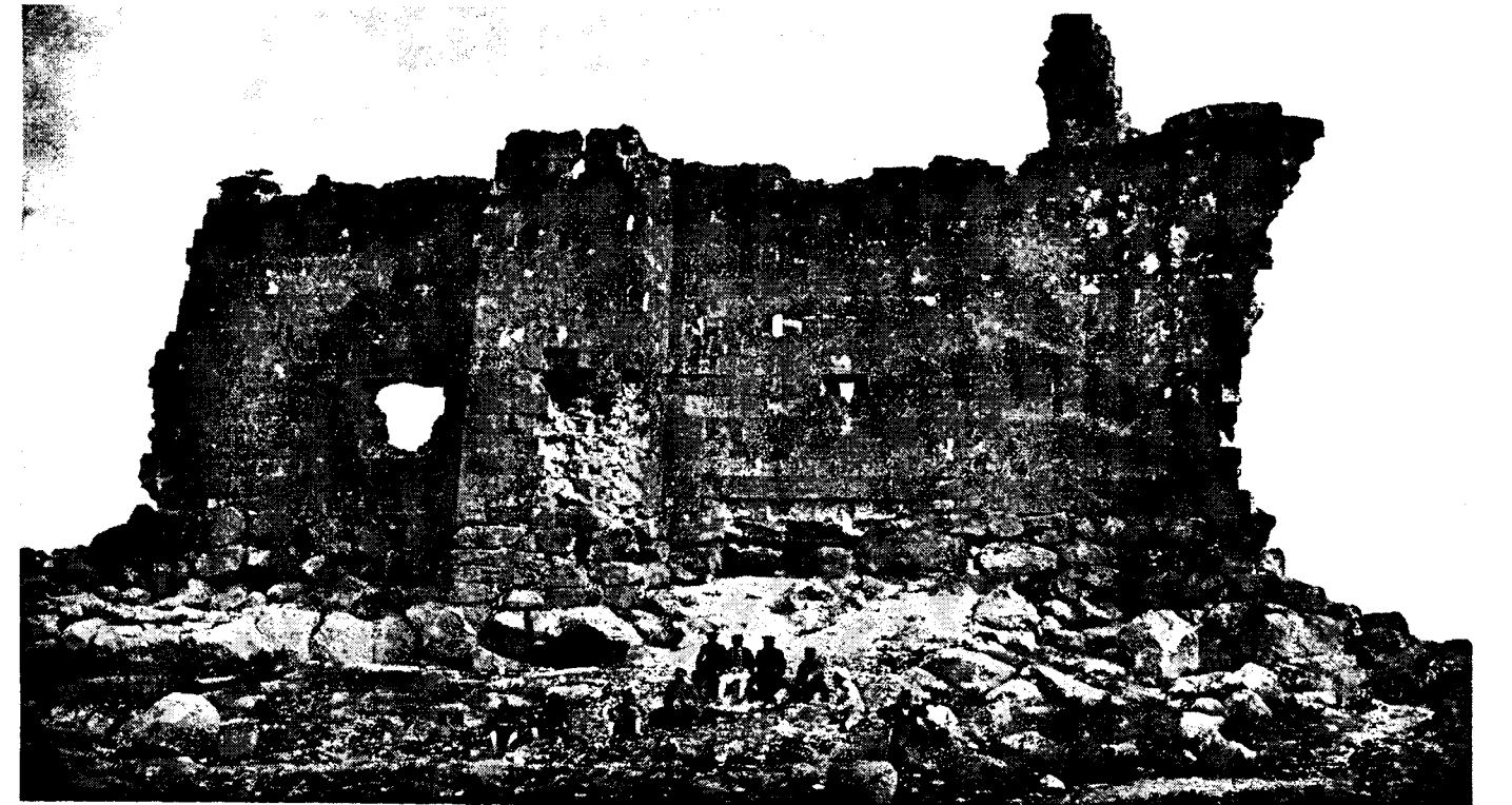
Նկ. 25. Միջնադարյան բերդի հյուսիսային պատը և տակի անշաղախ կիկլոպյան հիմերը
