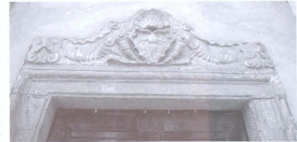
28. House (1773), no. 1, 1 Decembrie Street - Front view
