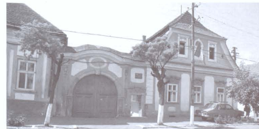
30. House (1764), no. 2, 1 Decembrie Street - Front view
